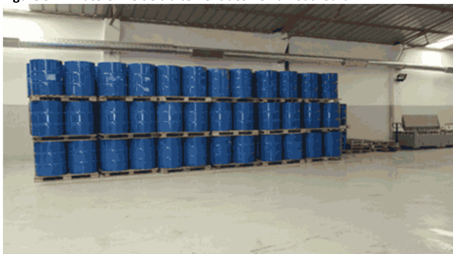
Figure 5.4 : Plateforme de traitement des PCB à Bouskoura
