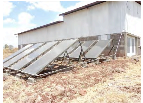
Foto 4. Paneles solares en abandono
