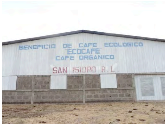
Foto 1 Fachada del Beneficio industrial
