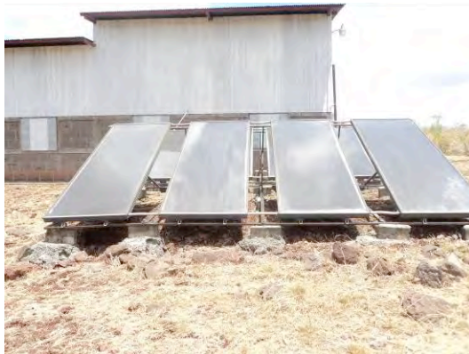
Foto 3. Paneles solares en abandono
