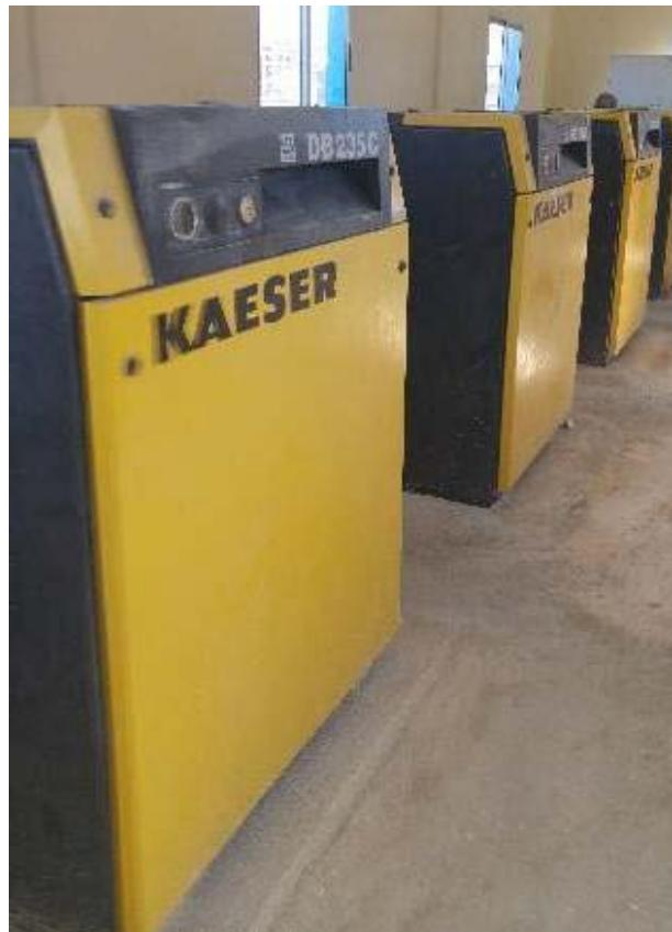
**FOTO 20:** Cámara de compresores para el sistema de aereación en la Planta de Tratamiento de Aguas Residuales Luyanó IV, Cuba, noviembre de 2016.
