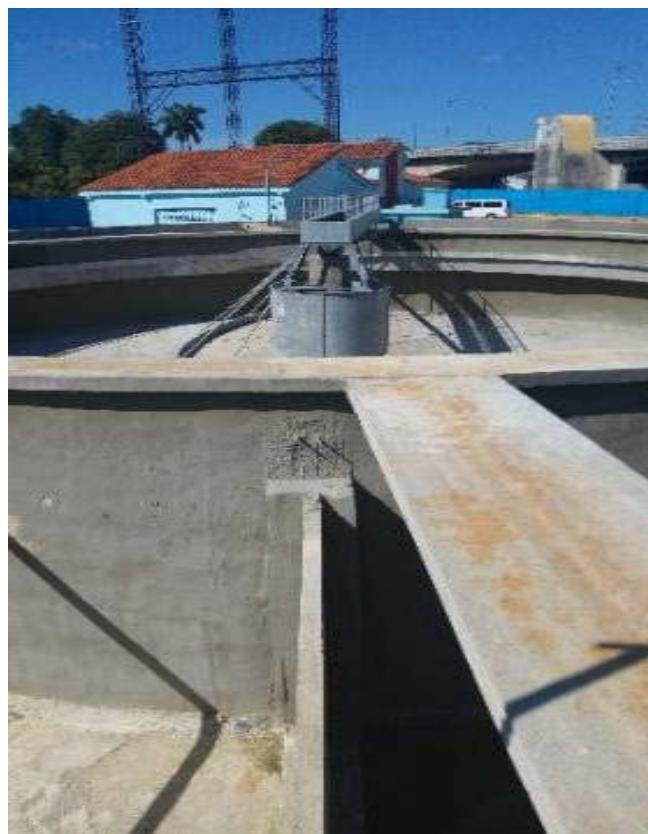
**FOTO 19:** Cámara de Aireación y Sedimentador Secundario
