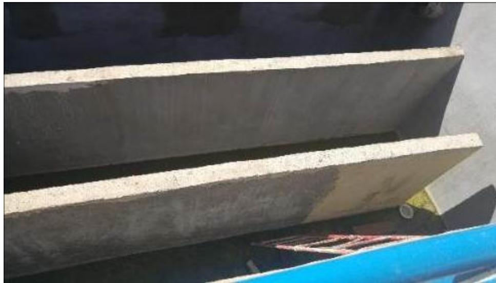
**FOTO 6: Tanque de Contacto para la Cloración en la Planta de Tratamiento de Aguas Residuales Luyanó IV, Cuba
