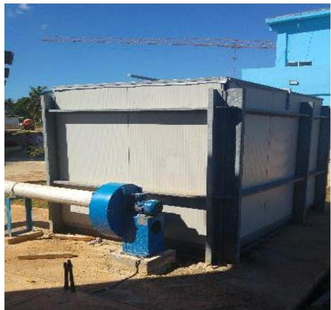
**FOTO 10:** Biofiltro de la Estación de Bombeo Principal en la Planta de Tratamiento de Aguas Residuales Luyanó IV, Cuba noviembre 2016.
