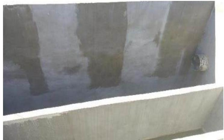
**FOTO 5: Tanque de Contacto para la Cloración en la Planta de Tratamiento de Aguas Residuales Luyanó IV, Cuba noviembre de 2016.**
