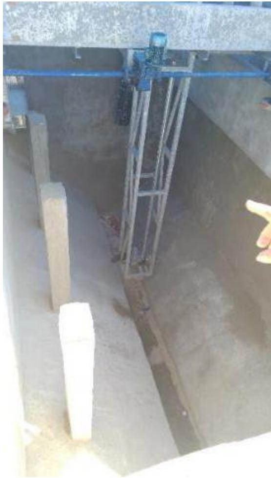
**FOTO 17:** Desarenador y desengrasador en la Planta de
