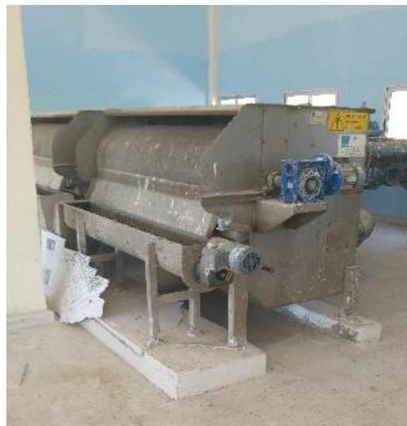
**FOTO 15: Filtros Rotatorios en la Planta de Tratamiento de Aguas Residuales Luyanó IV, Cuba**
