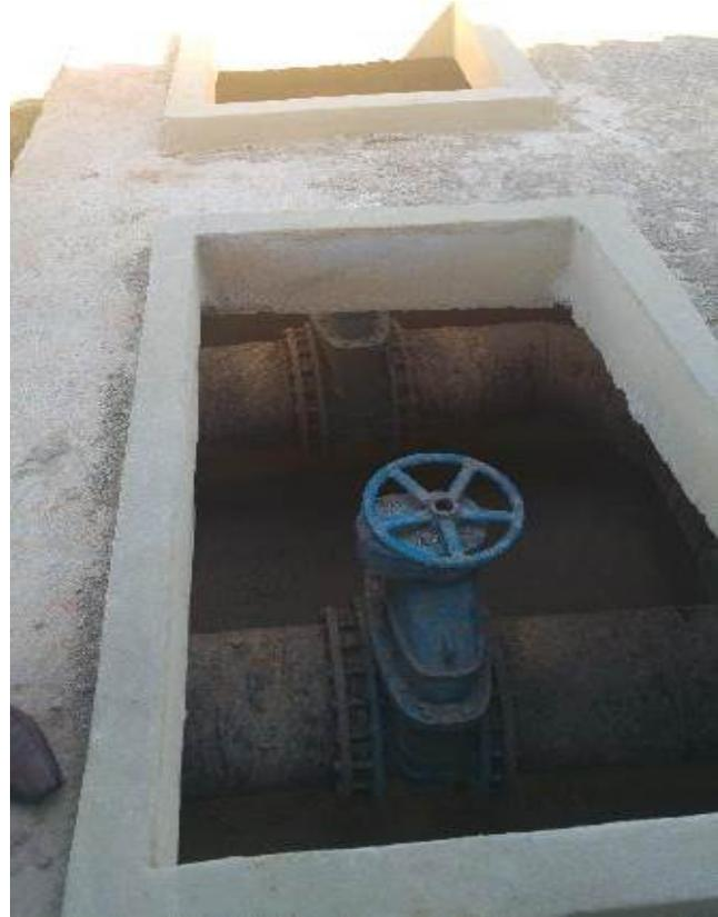
**FOTO 11:** Válvula de control hacia Pre Tratamiento de la Planta de Tratamiento de Aguas Residuales Luyanó IV, Cuba, noviembre de 2016.
