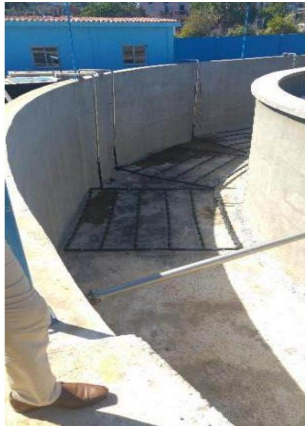
**FOTO 21:** Instalaciones internas para la Aireación en los Reactores en la Planta de Tratamiento de Aguas Residuales, Luyanó IV, noviembre de 2016.
