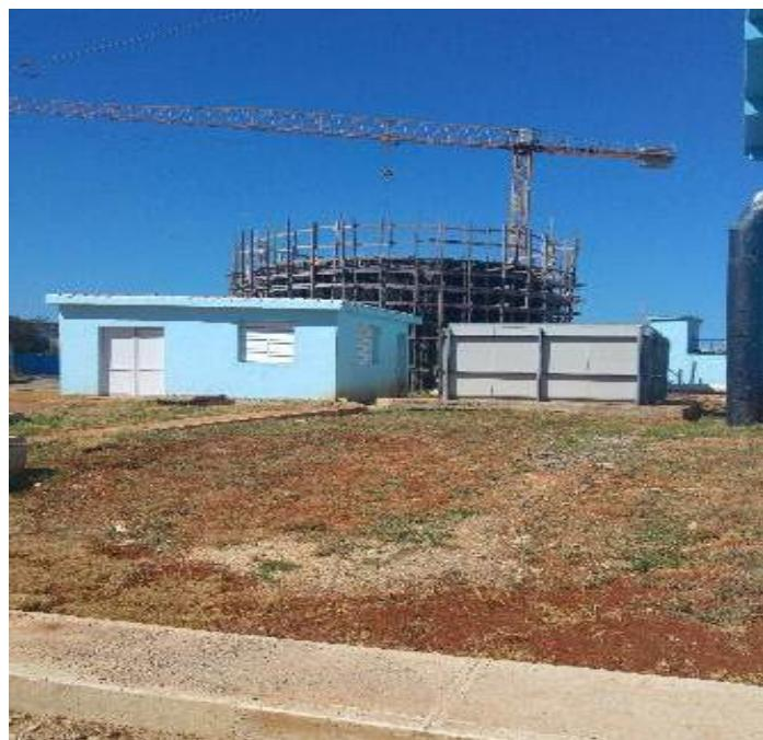
**FOTO 12:** Digestor Anaerobico, biofiltro y caseta de transformadores
